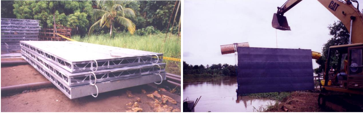
Figura 5. Paneles fabricados listos para su instalación y transporte al sitio.
